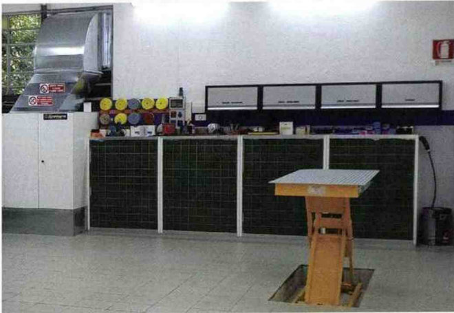
■ I soci della carrozzeria hanno scelto di installare il sistema tintometrico semi-automatizzato "MoonWalk" di PPG. Il colorificio di riferimento è Tognela Group di Varese.
